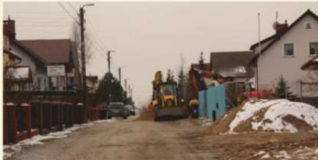
Rozpoczęto prace na ulicy Słonecznej
